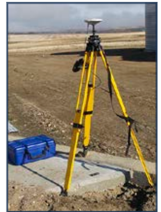
Survey the site.
